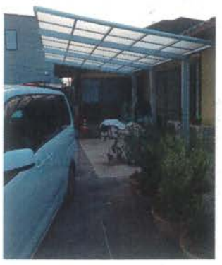
グリーンコープさんの助成金によりカーポート設置
