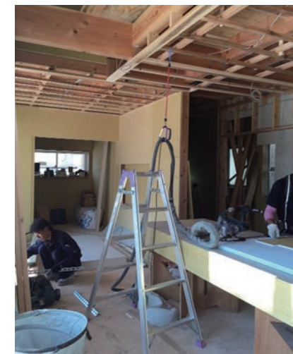
内部工事も進んでいます。
